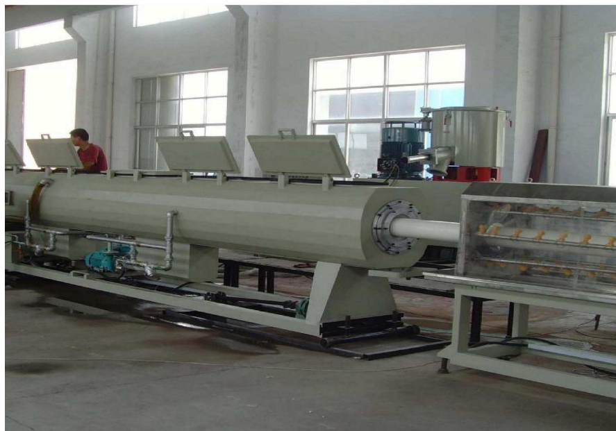
Figura 7.11. Tina de enfriamiento y de vacío
